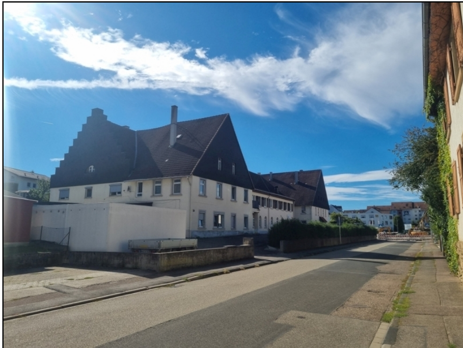
Ansicht Richtung nord
