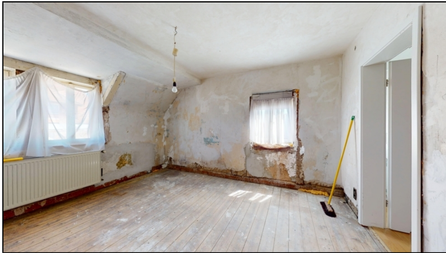
noch zu renovierender Raum
