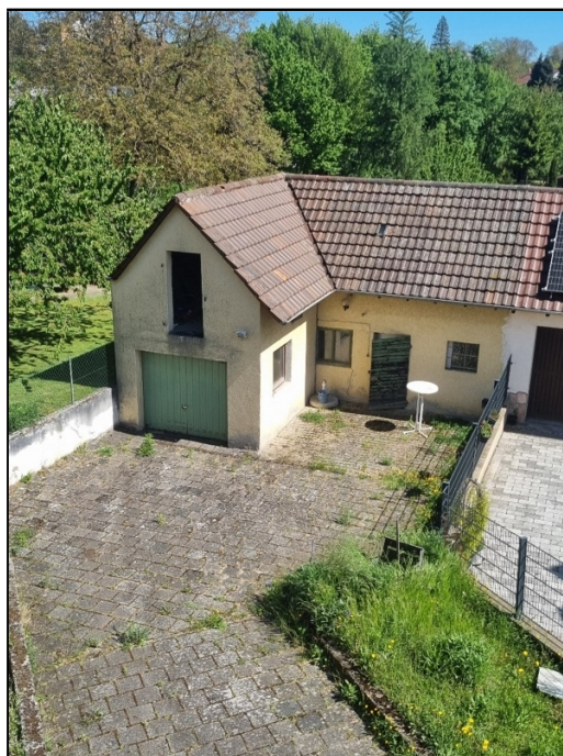
Nebengebäude und Garagenzufahrt
