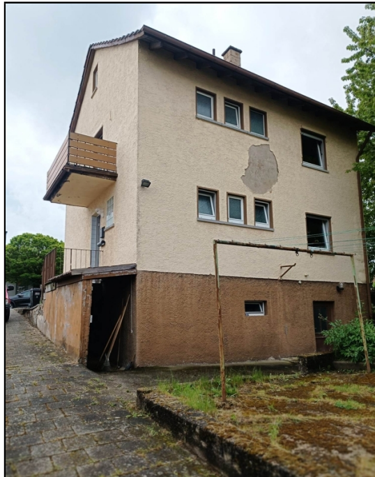
Ansicht von hinten
