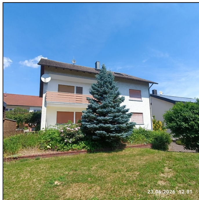
Ansicht vom großen Garten - Südseite
