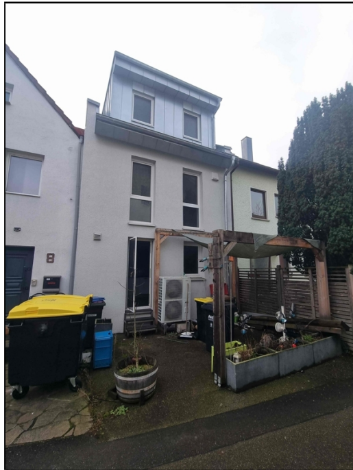
Ansicht von hinten
