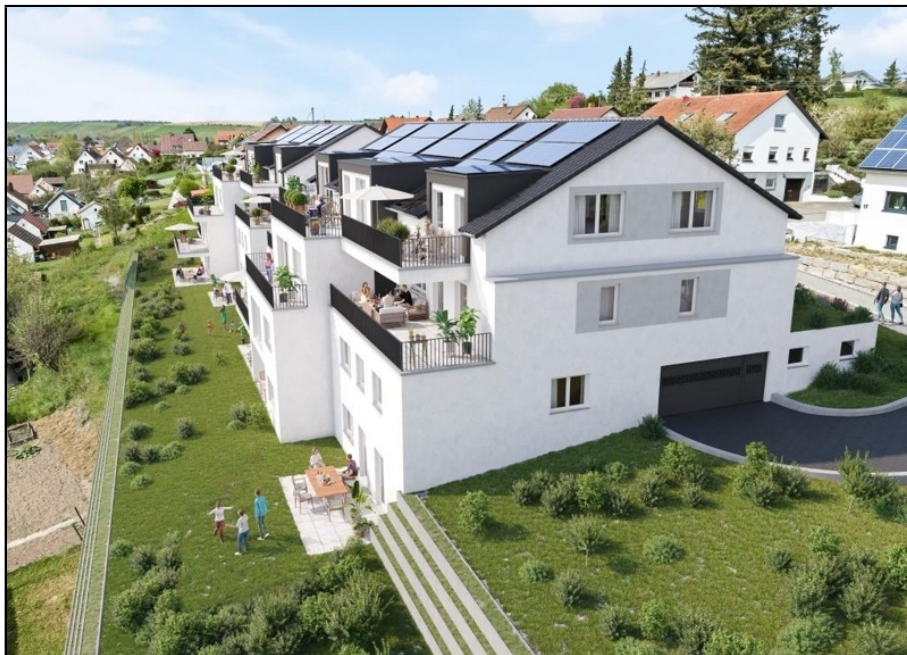
Sulzfeld K18 Südostansicht
