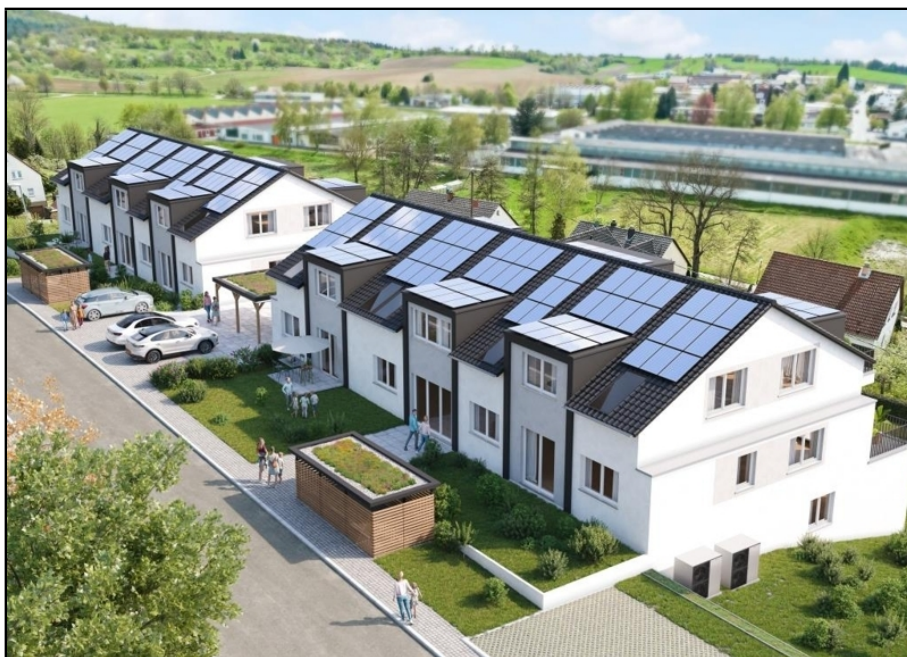
Sulzfeld K18 Nordansicht
